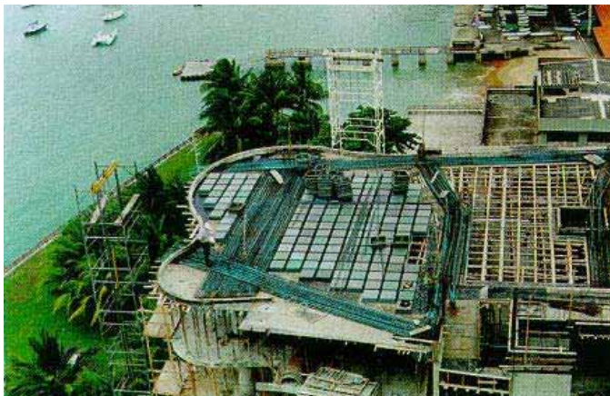
EDIFÍCIO ANCORADOURO, EM FORTALEZA O prédio de 18 pavimentos-tipo, erguido pela Cátech, exibe suas curvas em lajes nervuradas pretendidas
