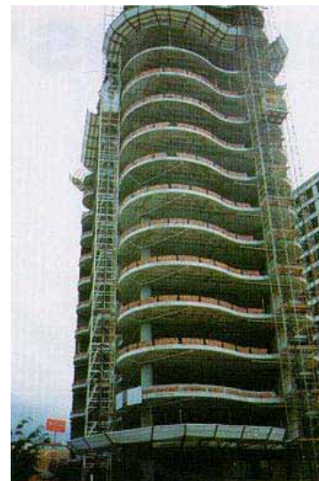
EDIFÍCIO ANCORADOURO, EM FORTALEZA O prédio de 18 pavimentos-tipo, erguido pela Cátech, exibe suas curvas em lajes nervuradas pretendidas
